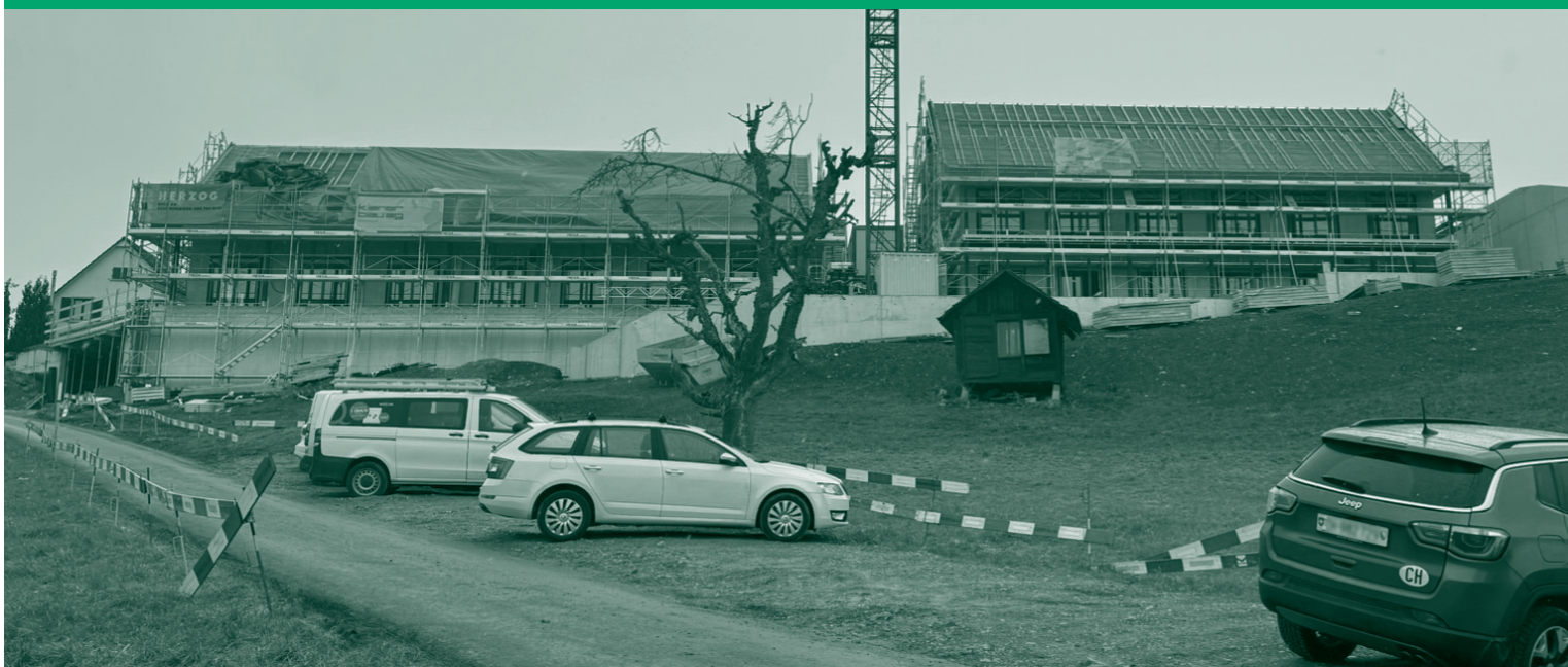
FERIENZENTRUM WANNENTAL – DER NEUBAU NIMMT FORM AN
